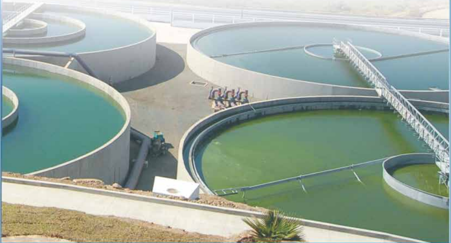
Planta de tratamiento Monte de los Olivos
